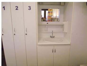
Felújított vizesblokk a Manuális pavilonban
